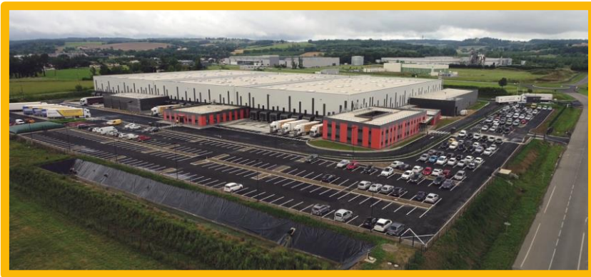
Sud-ouest à Damazan
