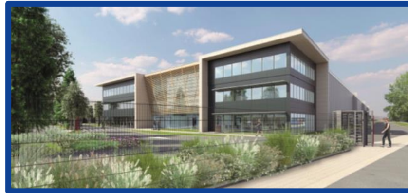
Sud-Est à Noves
